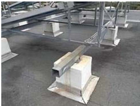
Photo 2. Vue sur plots, support des chauffe-eau solaire
