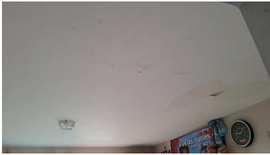
Photo 6. Traces d'infiltrations dans la chambre
