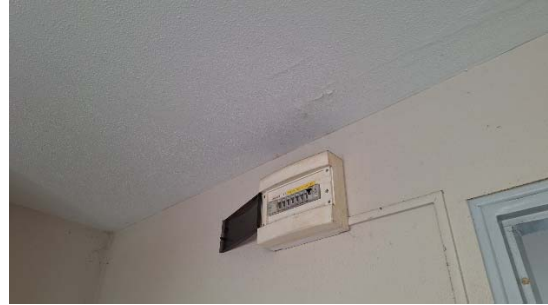
Photo 7. Traces d'infiltrations dans le salon – salle-à-manger -cuisine
