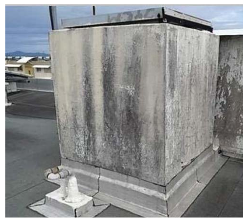
Photo 11. Solin de couverture de la cuve et trappe d'accès du bâtiment H
