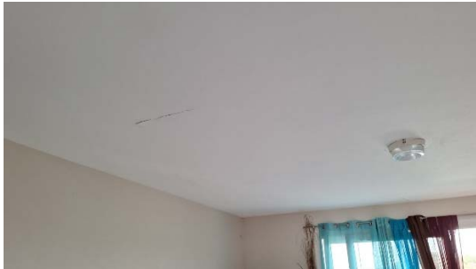
Photo 7. Traces d'infiltrations dans le salon – salle-à-manger -cuisine
