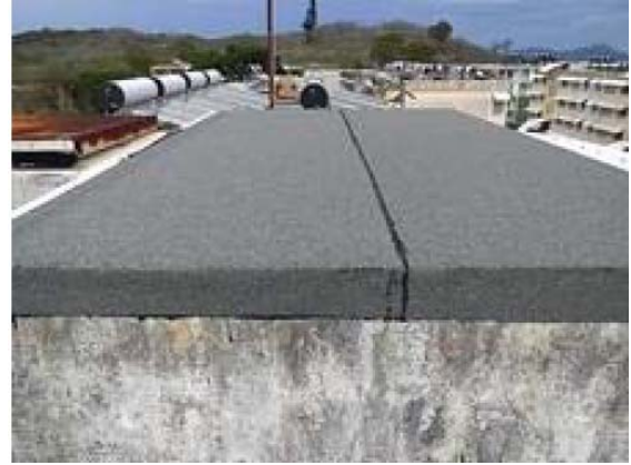
Photo 10. Vue sur étanchéité de couverture de la cuve
