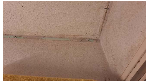
Photo 4. Décollement de la peinture du plafond dans la salle d'eau de l'appartement
