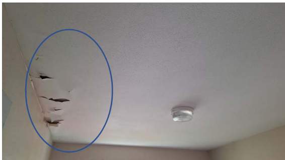
Photo 5. Traces d'infiltrations dans la chambre
