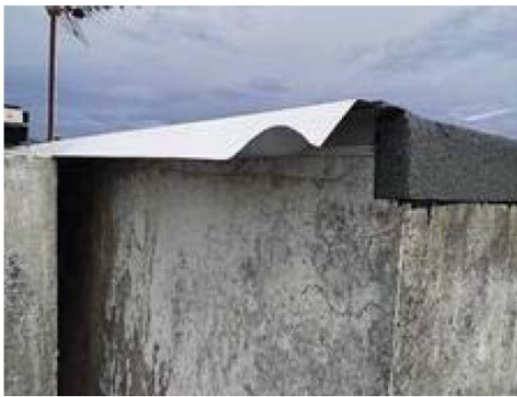
Photo 11. Solin de couverture de la cuve et trappe d'accès du bâtiment H
