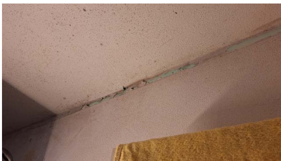
Photo 4. Décollement de la peinture du plafond dans la salle d'eau de l'appartement
