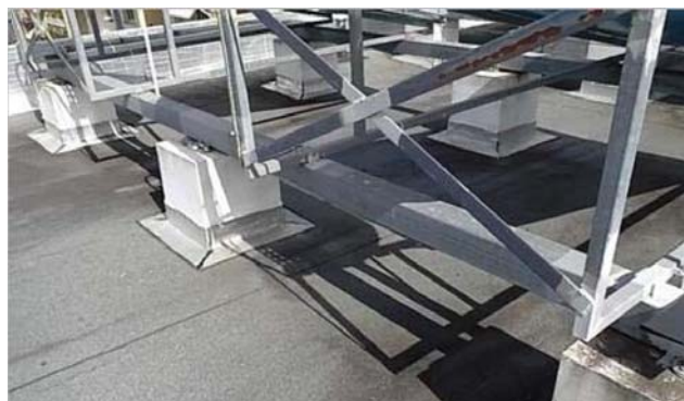
Photo 2. Vue sur plots, support des chauffe-eau solaire
